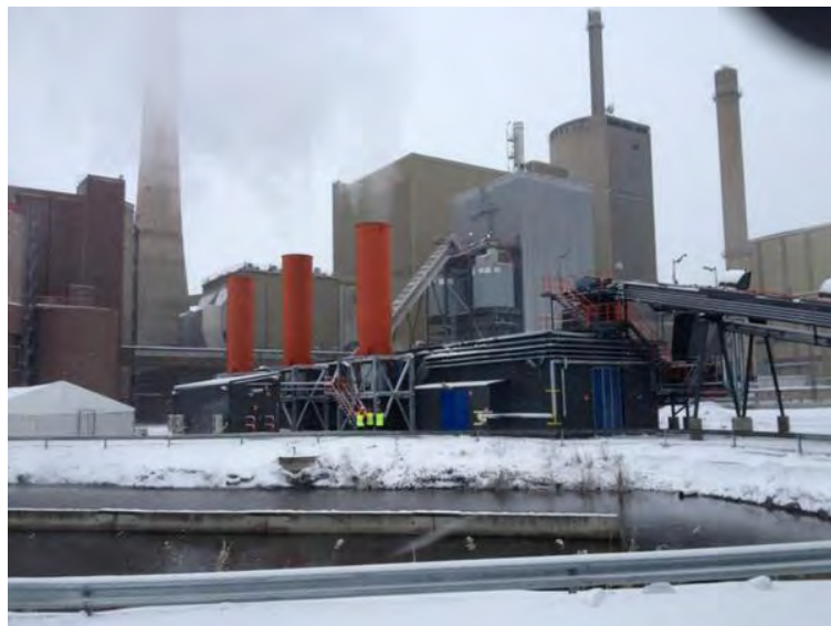
Kuva: Metso Oyj. Etualalla biomassan kuivaamo (punaiset piiput) ja kaasutuslaitos. Taustalla Vaskiluodon Voiman voimalaitos.
