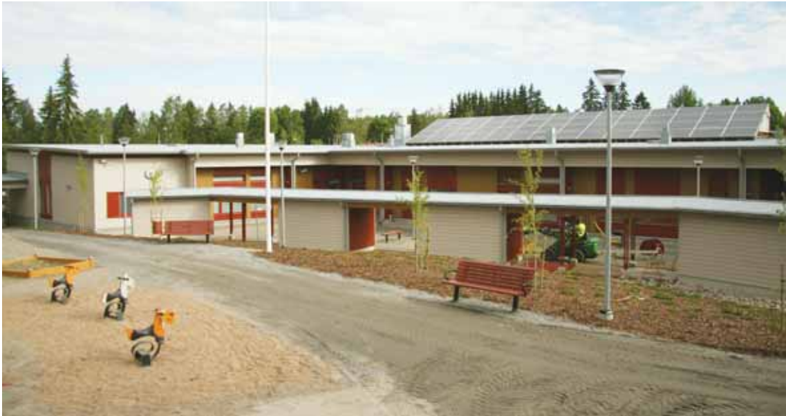
Luhtaan päiväkodin aurinkopaneelit sulautuvat rakennusmassaan luontevasti.
