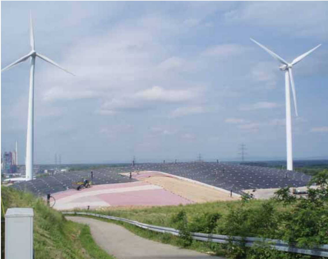
Voisiko Tampereen Tarastenjärven jätteenkäsittelykeskus joskus näyttää tältä? Kuva on Saksasta Karlsruheesta, missä kaatopaikka on muutettu energiapuistoksi, missä tuotetaan biokaasua sekä aurinko- ja tuulisähköä.
