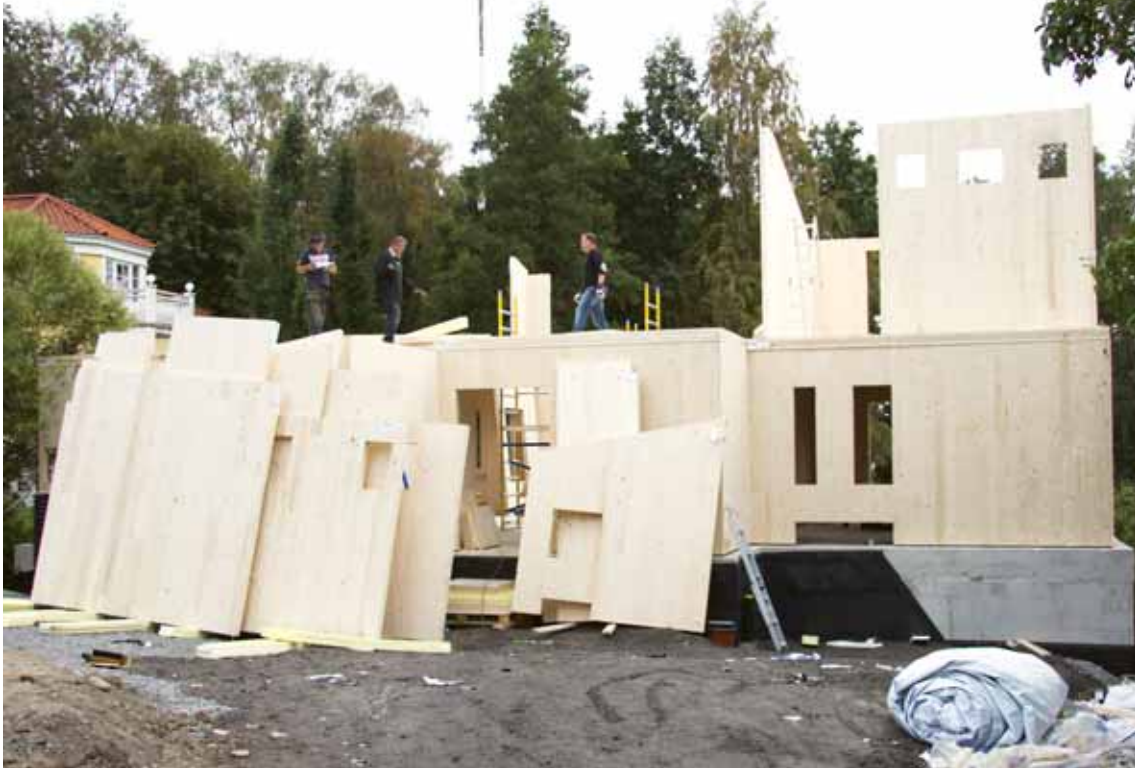
Massiivipuulementitalon pystytystä Tampereen Pispalassa.
