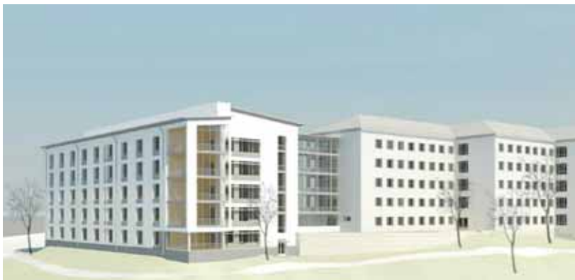
Koukkuniemen Jukola-talon peruskorjaus oli yksi Tapre-hankkeen pilotteja. Peruskorjauksessa pyrittiin löytämään energiatehokkaita ratkaisuja 1950-luvulla rakennettuun vanhainkotiin säilyttäen talon vanha ilme. Arkkitehtisuunnittelu BST-arkkitehdit Oy, toteutus Tampereen Tilakeskus.
