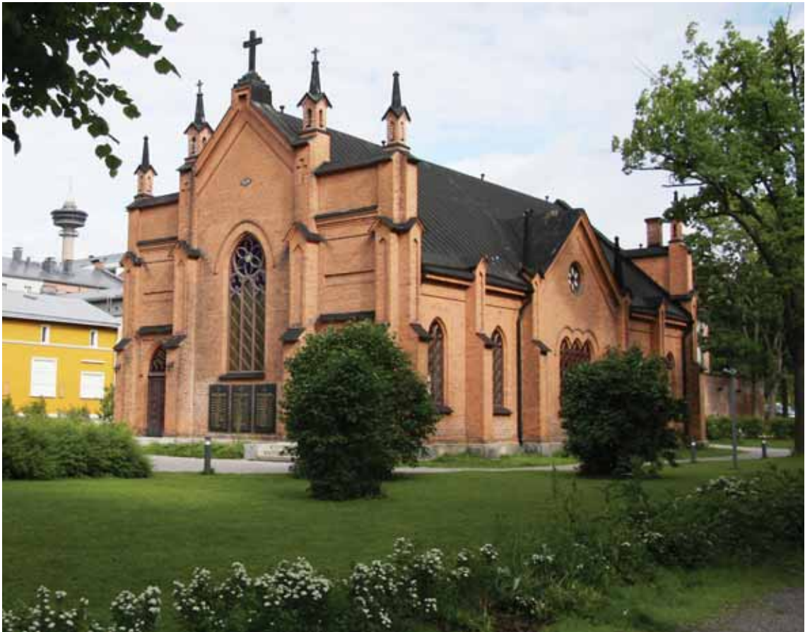
Finlaysonin kirkon elinkaari on jo nyt ollut pitkä, vuodesta 1879. Tampereen seurakunnat ovat mukana TAPRE-hankkeessa – energiatehokkuutta palvelurakennuksiin.
