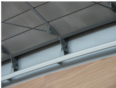
Kuva 6. Kattopalkkien pään nivelöinti.
