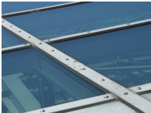
Kuva 8. Alumiiniset kiinnityslistat ja kumiset muototiivisteet
