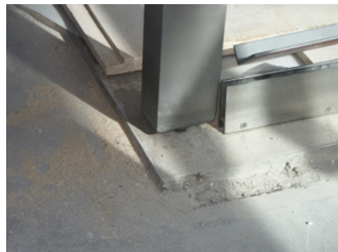
Kuva 7. Lasiseinän pystyliikkeen mahdollistava liikuntasauma.
