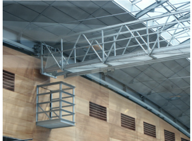
Kuva 10 a & b. Lasikaton ylä- ja alapuolella oleva moottoroitu huoltokelkka. Kelkkaan tulee järjestää turvallinen kulku.
