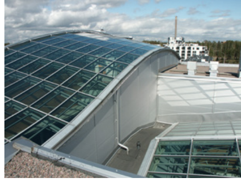
Kuva 5. Lasikatolta lumi putoaa umpikaton päälle.
