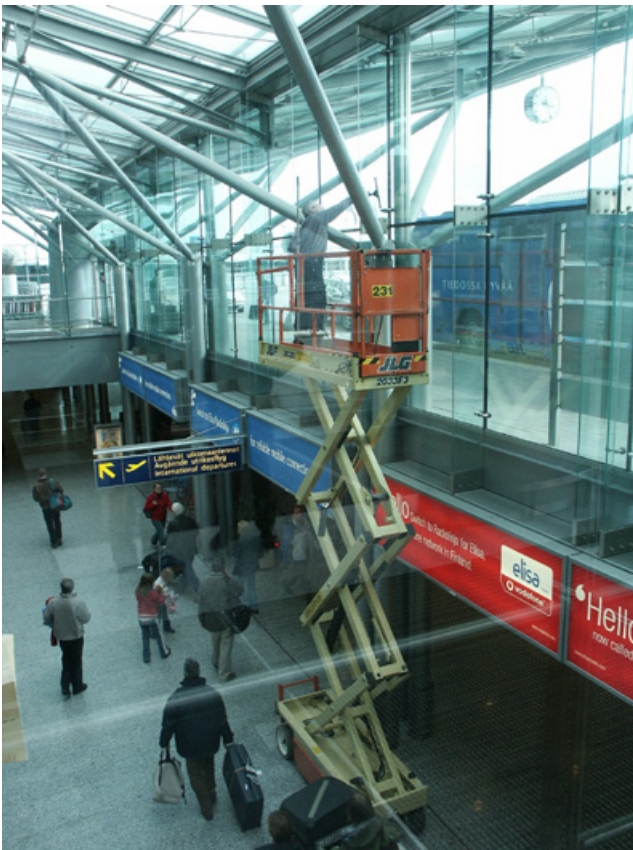
Kuva 11. Toinen vaihtoehto sisäpinnan puhdistamiseen on atriumtilaan tuotava henkilönostin, mikä tulee ottaa huomioon kulkuaukkojen mitoituksessa.
