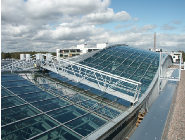
Kuva 10 a & b. Lasikaton ylä- ja alapuolella oleva moottoroitu huoltokelkka. Kelkkaan tulee järjestää turvallinen kulku.
