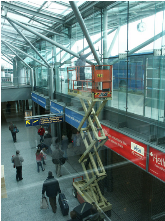
Kuva 14. Toinen vaihtoehto sisäpinnan puhdistamiseen on atriumtilaan tuotava henkilönostin, mikä tulee ottaa huomioon kulkuaukkojen mitoituksessa.
