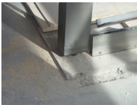
Kuva 10. Lasiseinän pystyliikkeen mahdollistava liikuntasauva.
