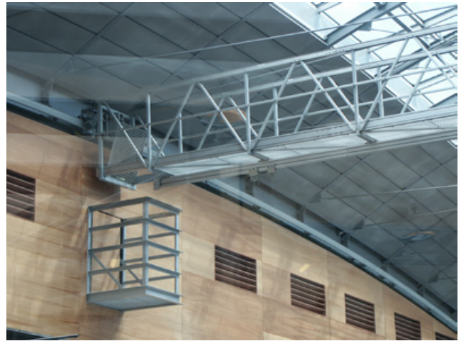
Kuva 13 a & b. Lasikaton ylä- ja alapuolella oleva moottoroitu huoltokelkka. Kelkkaan tulee järjestää turvallinen kulku.
