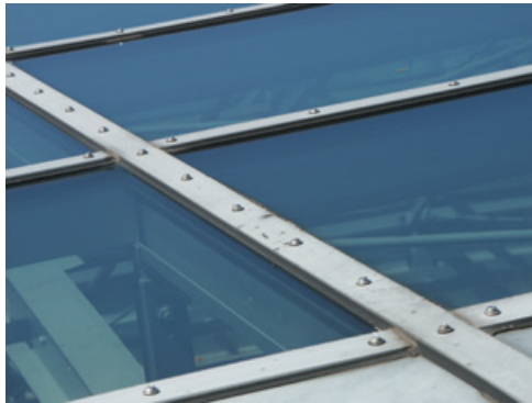
Kuva 11. Alumiiniset kiinnityslistat ja kumiset muototiivisteet.
