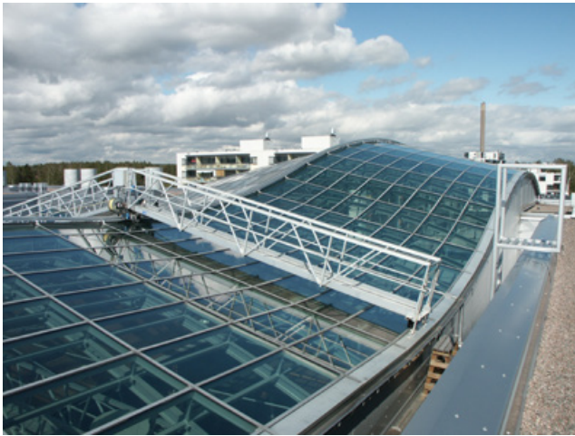
Kuva 13 a & b. Lasikaton ylä- ja alapuolella oleva moottoroitu huoltokelkka. Kelkkaan tulee järjestää turvallinen kulku.
