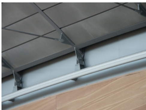
Kuva 9. Kattopalkkien pään nivelöinti.
