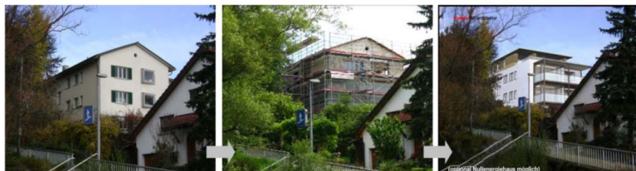
Kuva 31. Esimerkkikohde Zurichistä. ((lähde: http://www.empa-ren.ch/A50/Prefab_Retrofit.pps )
