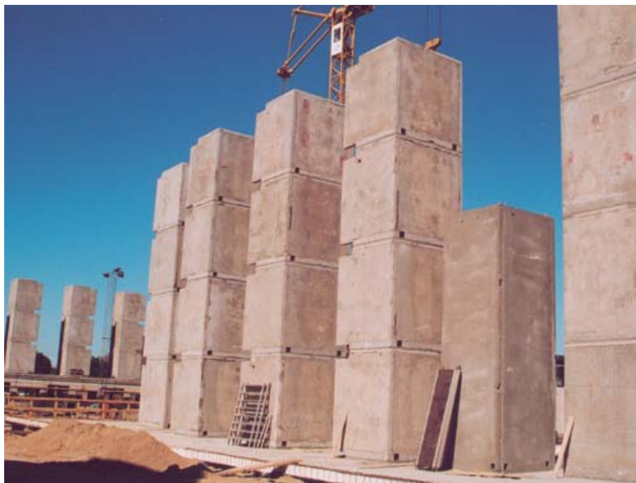
Kuva 10. Kylpyhuonemoduuleista kasattuja torneja. (lähde: http://www.ej-badekabiner.co.uk/ )
