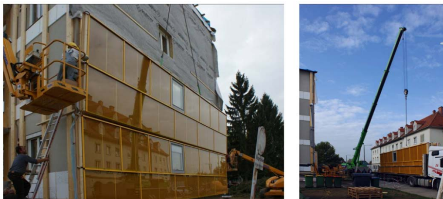
Kuva 29. Esivalmistettujen seinäelementtien asennusta. (lähde: http://www.empa-ren.ch/A50/Prefab_Retrofit.pps )
