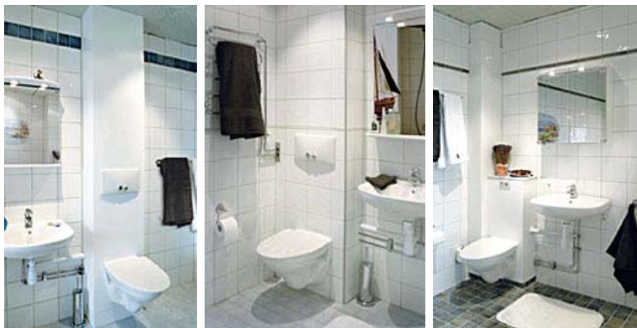
Kuva 14. Lintec asennuseinäelementtejä. Vasemmalta oikealle: Combikassett K47, Combikassett K60 ja Combimodul. (lähde: http://lintec.se/ )
