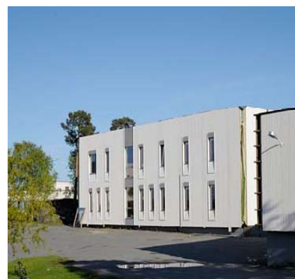
Kuva 35. TES Energy Facade-elementit asennettuna koerakentamiskohteessa Norjassa. (lähde: http://www.tesenergyfacade.com/pilotproject_risor_small_290509.pdf )
