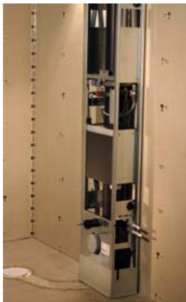
Kuva 13. Modulsystem C4 asennusvaiheessa sekä M4 valmiissa kylpyhuoneessa. (lähde: http://www.modulsystem.nu/ )
