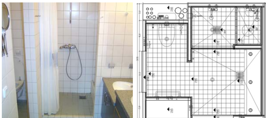
Kuva 11. Kylpyhuonemoduulit toimitetaan täysin kalustettuina. (lähde: http://www.ej-badekabiner.co.uk/ )
