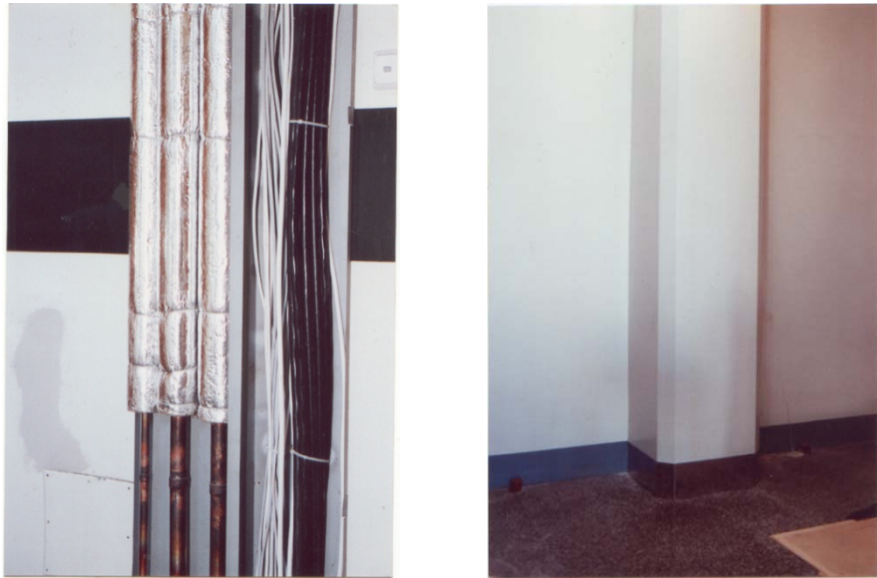
Kuva 18. Moduc-hormielementti toimitetaan valmiiksi putkitettuina ja asennettuna. (lähde: http://www.moduc.fi/ )
