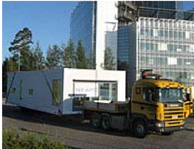
Kuva 36. Neapo Penthouse-elementti toimitetaan työmaalle valmiina, jopa asuntokohtaisina tilaelementteinä. (lähde: http://www.neapo.fi/ )
