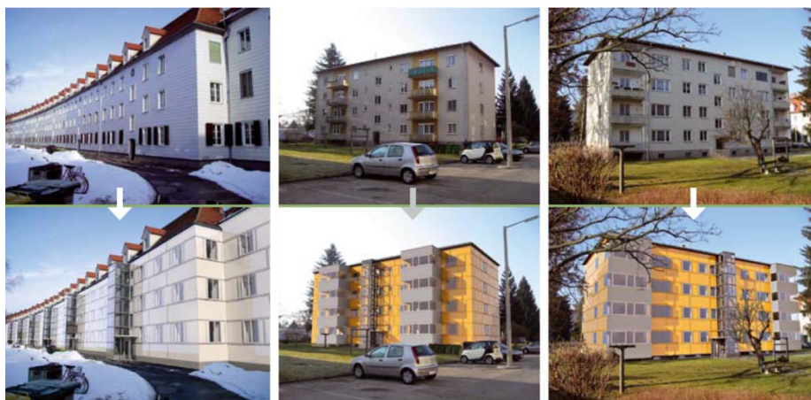
Kuva 28. Esimerkkikohteita Grazissa. Kaksi 2008 valmistunutta kohdetta (oikealla), kaksi työn alla 2009 olevaa kohdetta (keskellä) ja yksi suunnitteilla (vasemmalla). (lähde: http://www.empa-ren.ch/A50/Prefab_Retrofit.pps )
