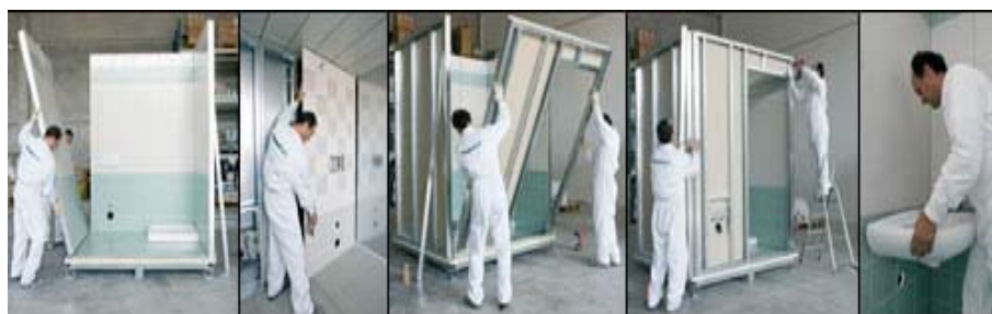
Kuva 9. TecnoIN Pod-kylpyhuonemoduulin kasausprosessi. (lähde: http://www.tecnoin.ae/ )
