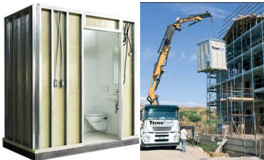
Kuva 8. Vasemmalla: TecnoIN Pod -kylpyhuonemoduuli, oikealla: kylpyhuonemoduulia nostetaan rakennukseen. (lähde: http://www.tecnoin.ae/ )
