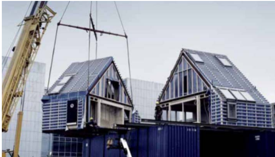
Kuva 32. Soltag-konsepti koostuu tehtaalla esivalmistetuista elementeistä. (lähde: http://www.velux.com/SiteCollectionDocuments/_PDF-Documents/Brochures/SOLTAG.pdf )
