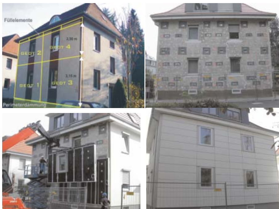
Kuva 21. Tyhjiöeriste-elementtien asennus (lähde: http://sanierungsdaemmung-vip.de/hp379/Sanierungsdaemmung.htm?ITServ=C264d70aaX122cdc525ddXY4f78 )
