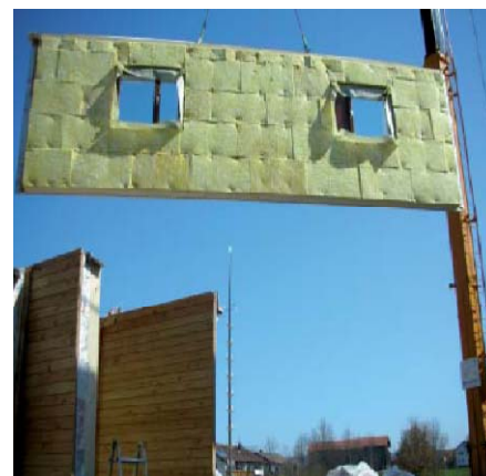
Kuva 34. TES Energy Facade-metodi perustuu vanhan rakennuksen tarkkaan mittaamiseen, 3D-mallin luomiseen, elementtien valmistukseen tehtaalla ja valmiiden elementtien asennukseen työmaalla. (lähde: http://www.tesenergyfacade.com/TES%20EnergyFacade.pdf )
