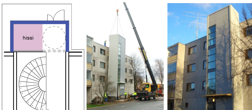
Kuva 25. Tehtaalla valmistetun Neapo Tubetower-hissitornin asennus rakennuksen kylkeen tapahtuu nopeasti (lähde: http://www.neapo.fi/suomi/www/page.php?id=10 )
