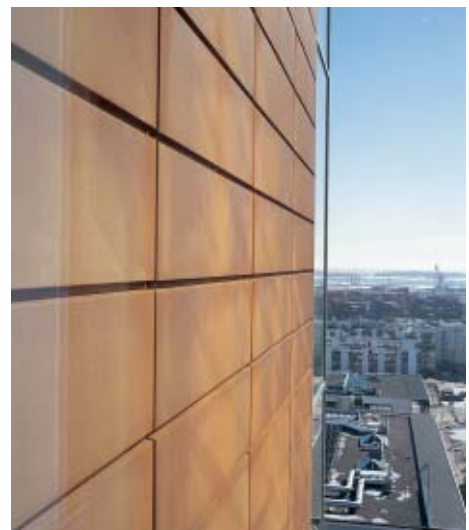
Vuoden 2000 teräsrakennepalkinnon saaneessa talossa Cor-Ten -terästä on käytetty niin rungossa kuin yksityiskohdissa.
